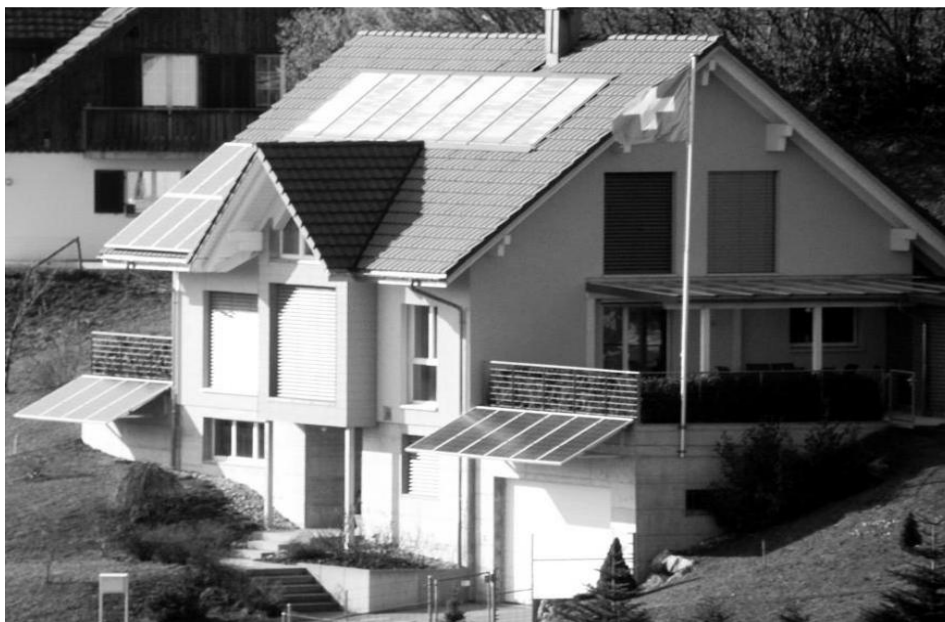
Tag der Sonne am 7. Mai 2011: Solaranlage Wohnhaus Rudisuhli, Oberhelfenschwil
