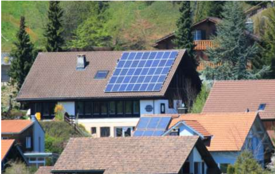
Tag der Sonne am 12. Mai / Besichtigung Photovoltaikanlage an der Feldstrasse 39
