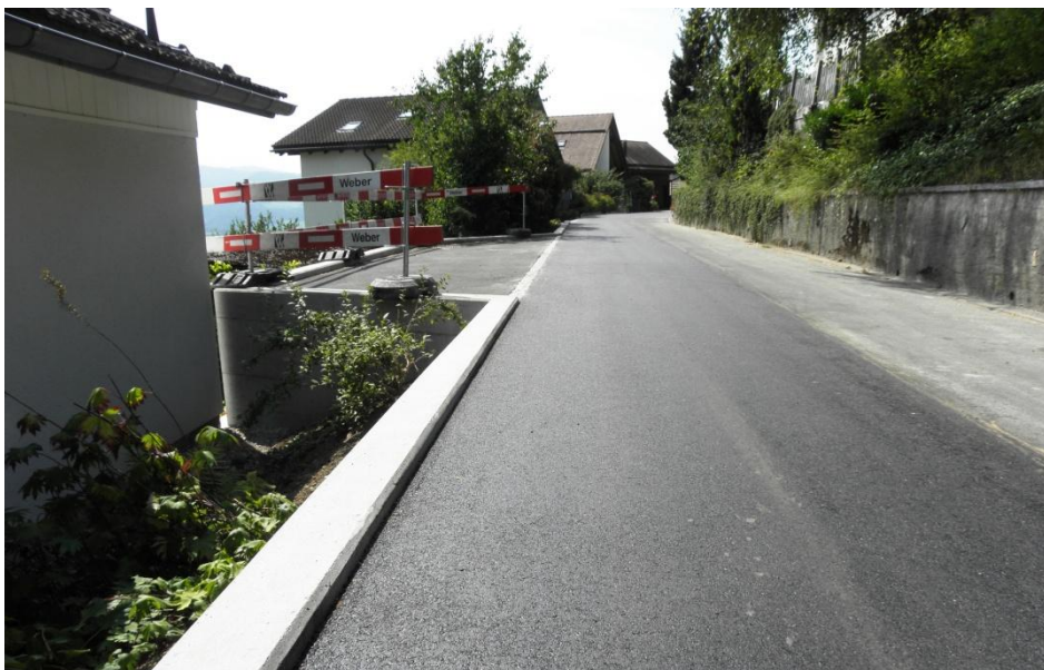
Die frisch sanierte Sonnenbergstrasse.
