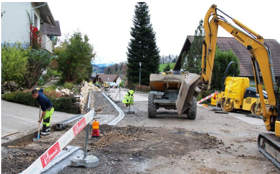
Sanierungsarbeiten an der Feldstrasse.
