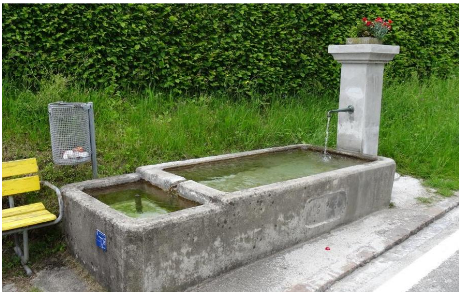
Frisch sanierter Brunnenstock am Dorfbrunnen auf der Wasserfluh
