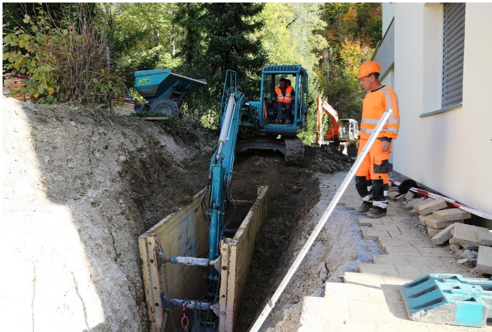
Kanalisation Schwanden: 1. Bauetappe mit Anschluss an die Kanalisation in Lichtensteig
