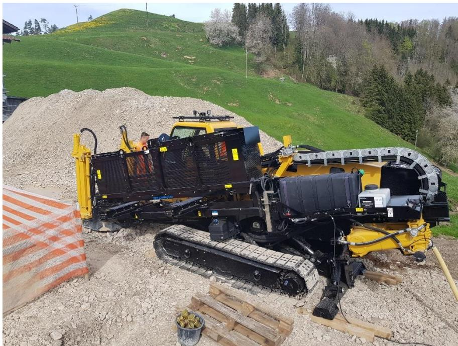
In Schwanden sind die Bohrungen fur die neuen Abwasserleitungen im Gange.
