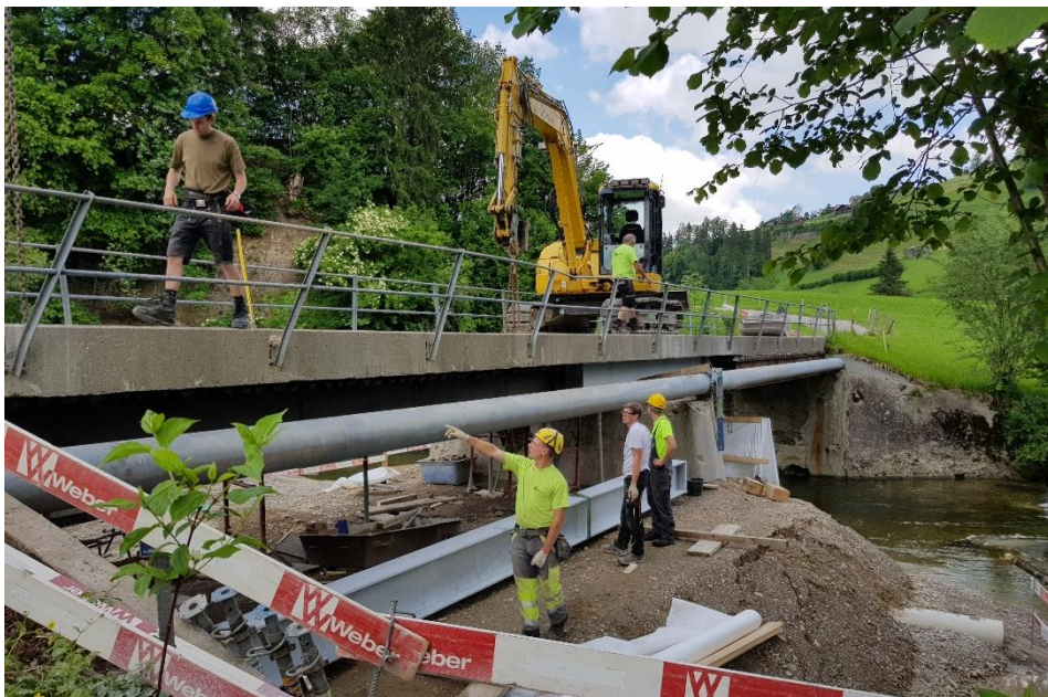
Die Rennenbrücke in Necker wird saniert.
